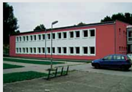
Tělocvična ZŠ Hulín
