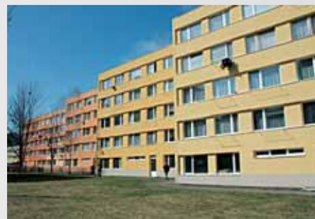
Rekonstrukce panelových domů, ul. Mostecká, Kladno
