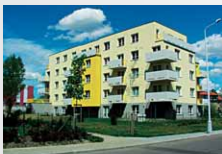
Rekonstrukce bytového domu, ul. Navigátoru, Praha 6
