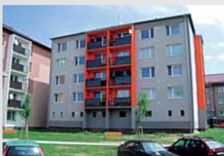
Rekonstrukce bytového domu Hulín, ul. Višňovce
