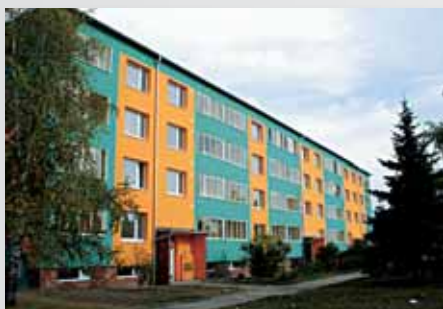
Rekonstrukce panelového domu, ul. J. Fučíka, Chropyně
