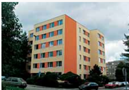
Rekonstrukce panelového domu, ul. Jelínková, Praha
