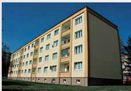
Rekonstrukce panelového domu, ul. Vitry, Kladno
