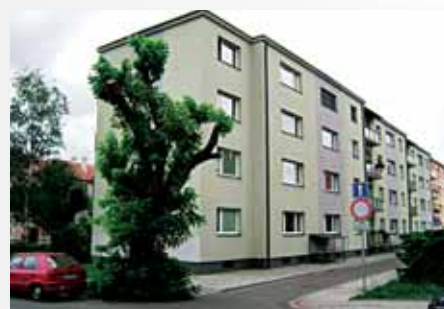
Rekonstrukce bytového domu, ul. Bulharská, Prostějov
