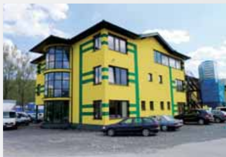
Administrativní budova, ul. Slavkovská Kežmarok
